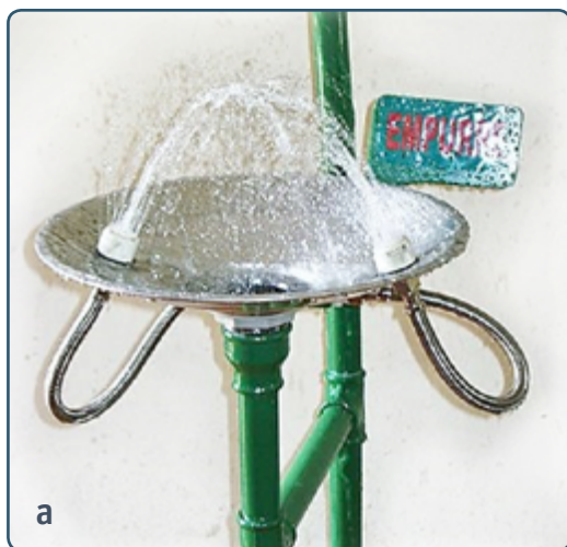
Figura 2. Lava-olhos (a) e ducha de emergência (b)
