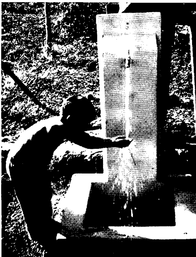
Escena típica en una villa del Perú muestra un hidrante público recién instalado.
