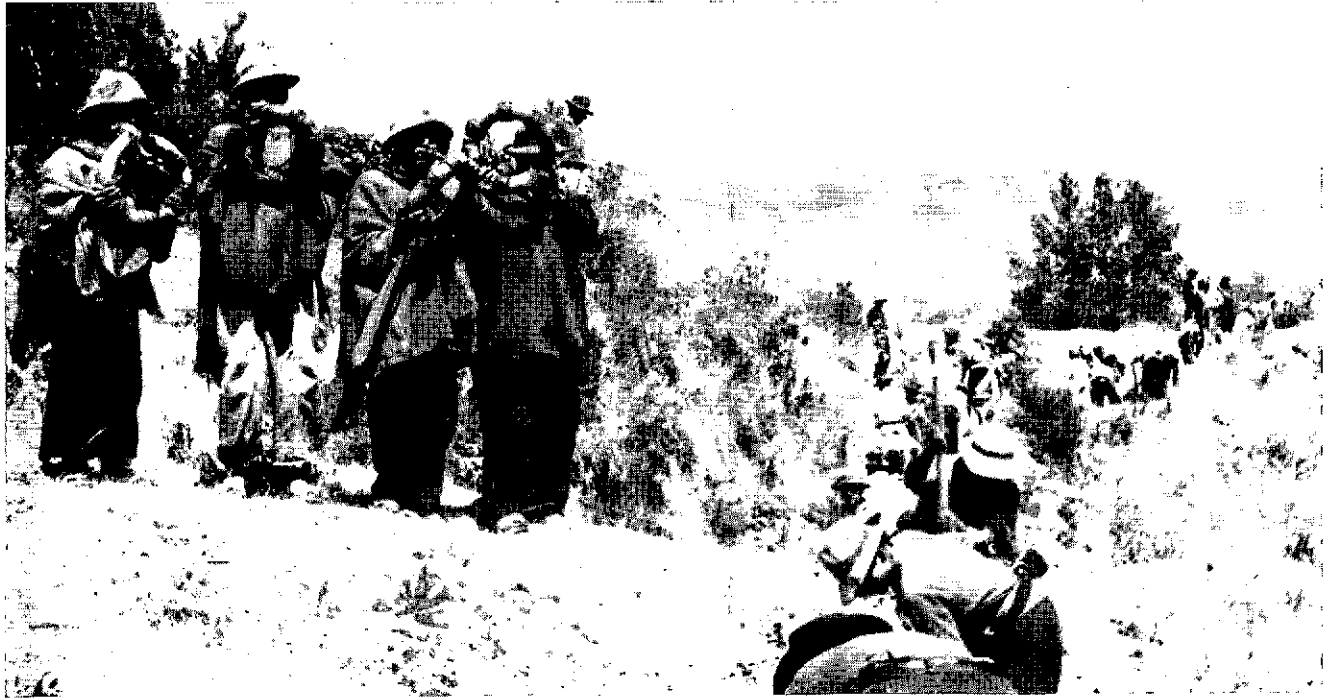
Los habitantes de una comunidad andina del Perú participan activamente en las obras de construcción de servicios de agua potable rural.
