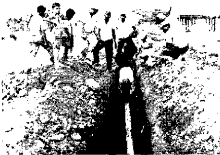
4. Se colocan las tuberías.
