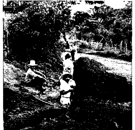
3. La comunidad participa en la excavación para instalar las tuberías.
