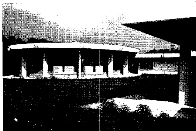
Edificio (en construcción) para la Escuela de Enfermeras Dentales, Jamaica.
