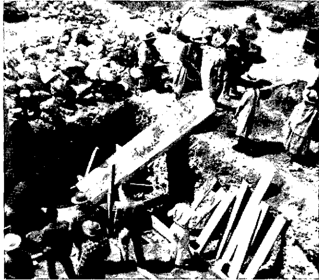
Paca, Junín, Perú: los pobladores, bajo la dirección de un experto, trabajan en la construcción de su propia represa.
