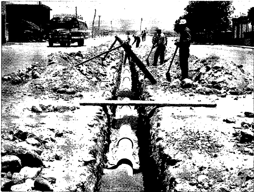
AGUA POTABLE PARA LA CIUDAD. OBREROS INSTALANDO UNA TUBERÍA DE 10 PULGADAS, DE ASBESTO-CEMENTO, EN AREQUIPA, PERÚ.
