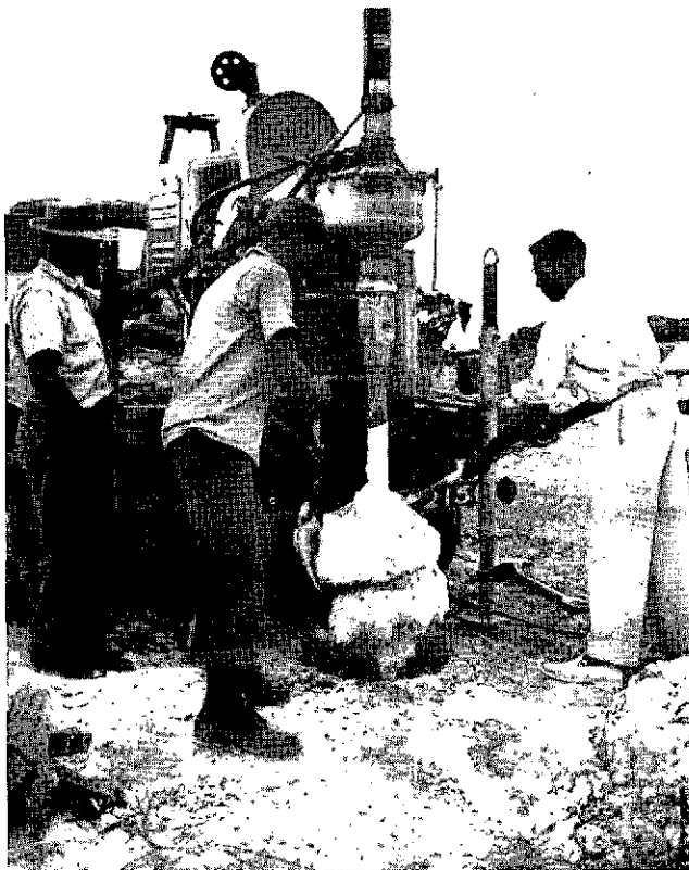
EQUIPO ESPECIAL, EN USO EN EL CARIBE, PARA CONSTRUIR LETRINAS EN TERRENO ROCOSO O EN FORMACIONES CORALÍFERAS.
