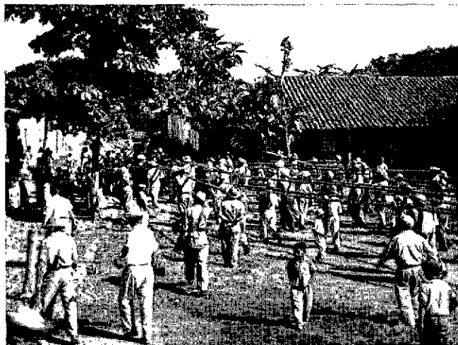
Hombres, mujeres y niños transportan tuberías hasta Loma de Ramas, Guazapa, en El Salvador, cinco millas montaña arriba, para instalar un sistema de abastecimiento de agua
