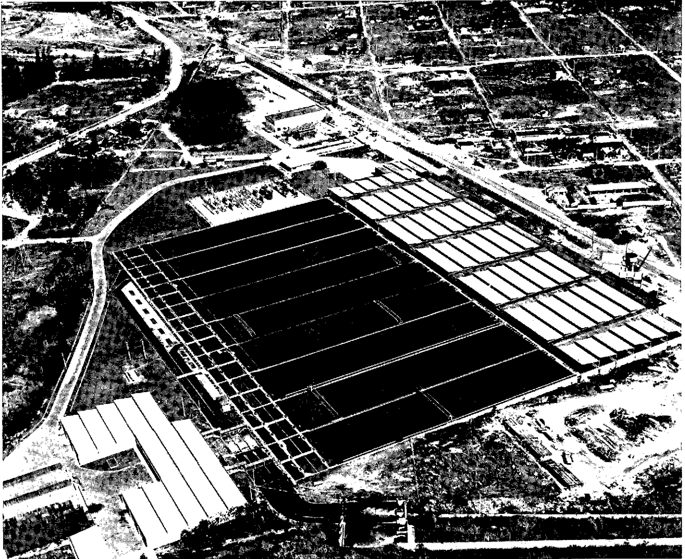
Planta de tratamiento de agua Guandu, principal fuente de abastecimiento de Guanabara, Brasil.
