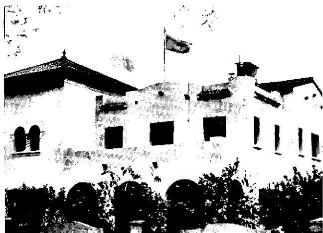
Edificio actual del Centro Panamericano de Ingeniería Sanitaria y Ciencias del Ambiente (CEPIS), en Lima, Perú.
