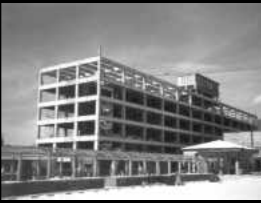
Reforzamiento del Hospital General del Instituto Salvadoreño del Seguro Social (ISSS).
