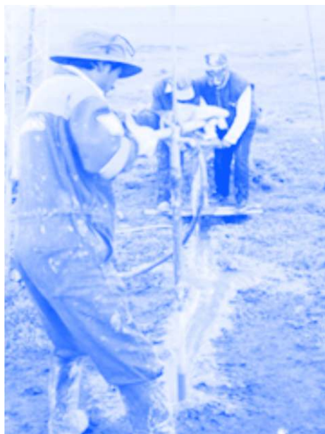
Figura 18. Perforación manual por percusión-rotación y lubricación con bentonita
