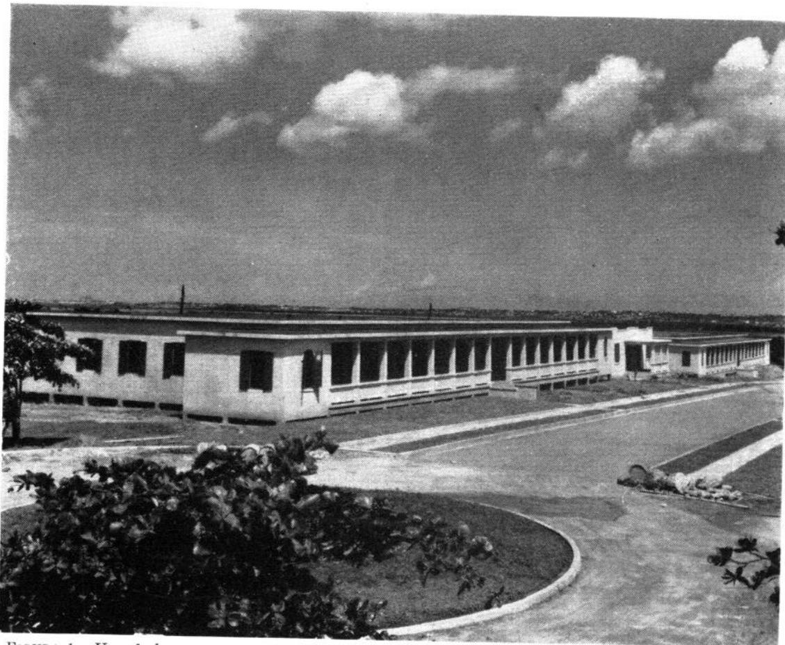
FIGURA 1.—Una de las nuevas unidades de 100 camas del Sanatorio para Tuberculosos en Río Piedras, construídas a precio módico, de cemento armado.
