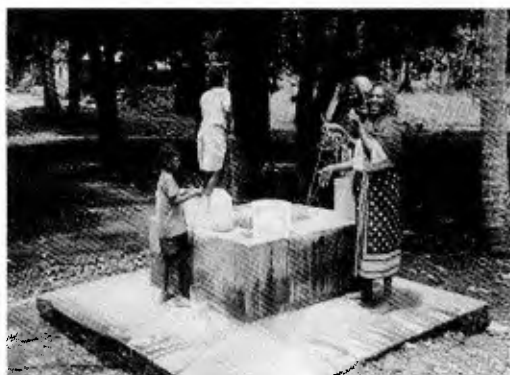
El clásico pozo excavado con todas sus condiciones para la contaminación
