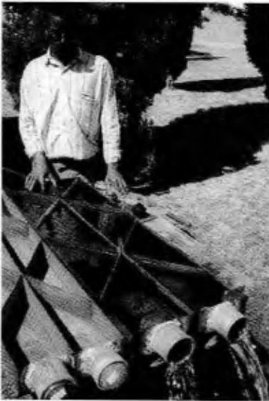
Instalación típica de un equipo de radiación UV con lámpara fuera del agua
