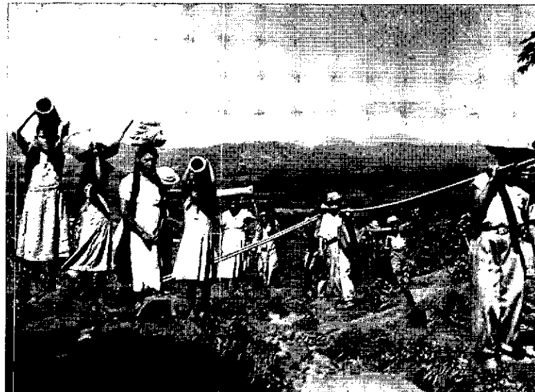
Los vecinos de este pueblo participan en la instalación de una tubería para el nuevo sistema de abastecimiento de agua.
