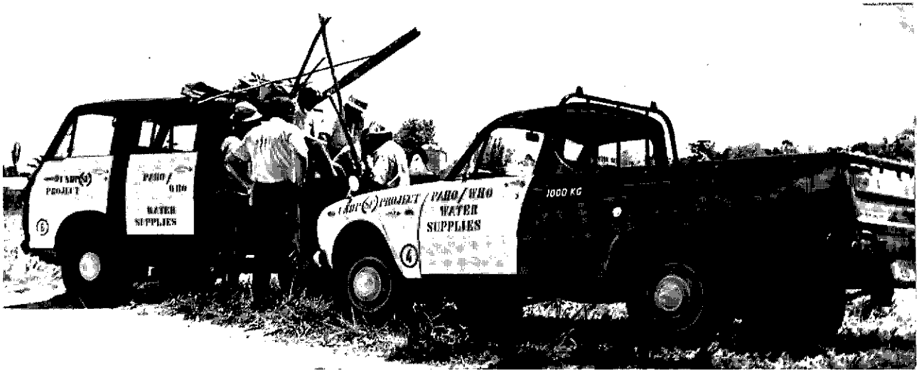
En Surinam, un equipo de perforación de pozos se prepara para comenzar su trabajo.
