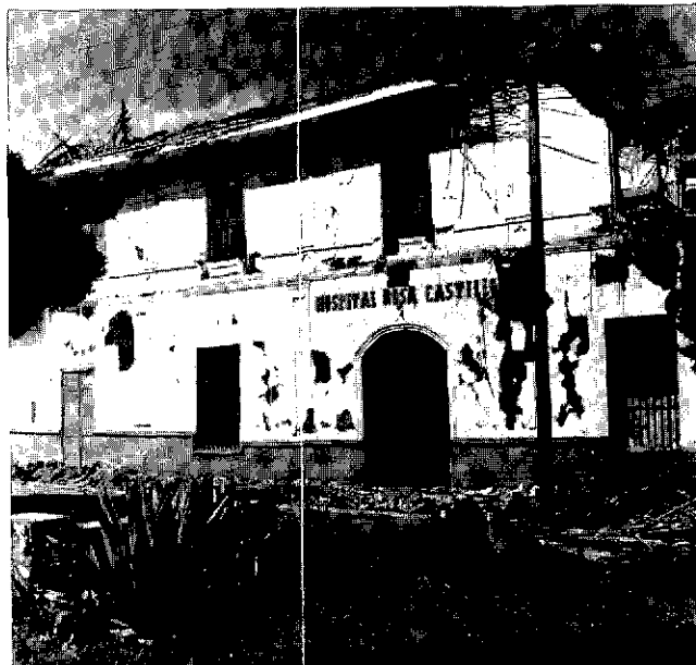
Daño sufrido por un hospital como consecuencia del terremoto del 31 de mayo de 1970 en el Perú.
