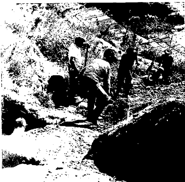
En Chile residentes de un pueblo asisten en la apertura de zanjas en un proyecto de saneamiento rural en terreno difícil.
