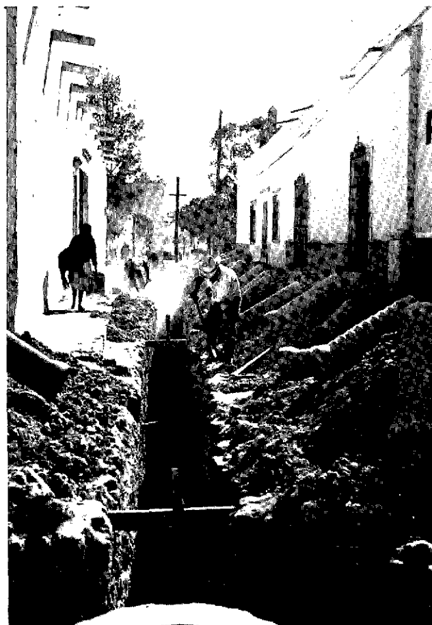
Excavación de zanjas para alcantarillado.
