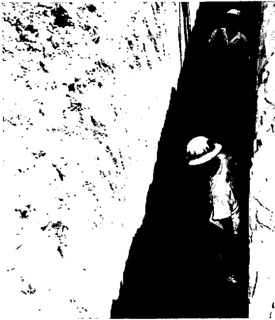
Excavación para tuberías.
