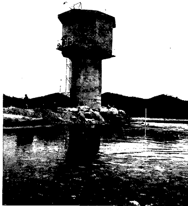
Pozo de captación tipo Ranney y caseta de bombeo en el sistema del Río Papagayo, México.
