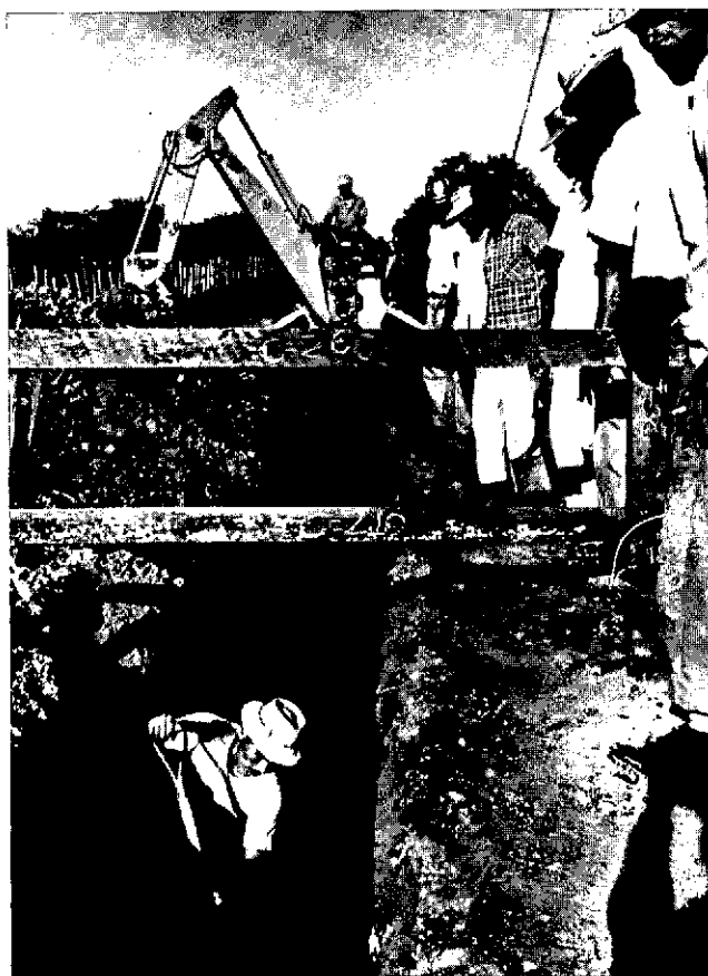
Construcción del alcantarillado sanitario de la ciudad de Chitré, Panamá.
