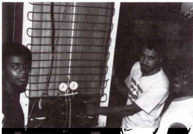
Participantes del curso de entrenamiento para los técnicos de la cadena de frío siguen su adiestramiento en el mantenimiento preventivo y la reparación de refrigeradoras.
