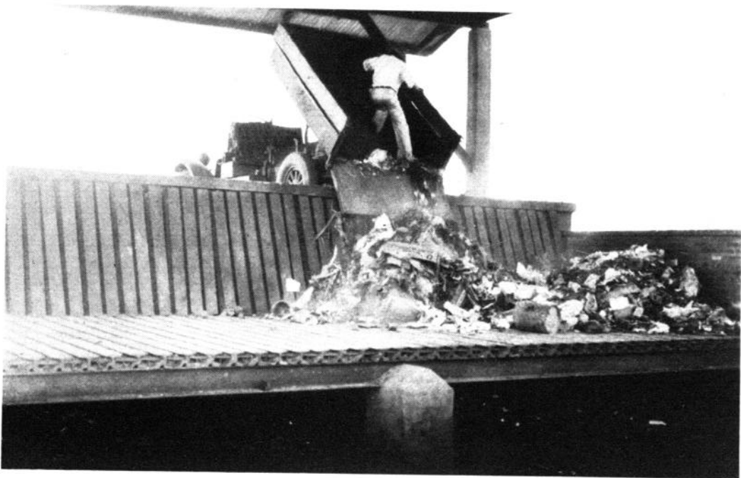
FIG. 2.—Vista de cerca. Los rieles están colocados a 5 cm uno del otro. La parrilla tiene una ligera inclinación hacia el frente. Los rieles en el fondo tienen también una inclinación, formando un ángulo con el muro de retención para facilitar la ventilación.
