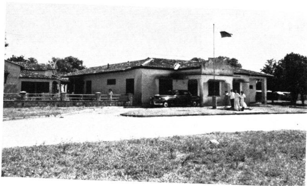
Vista general de la Unidad Sanitaria de Antón.
