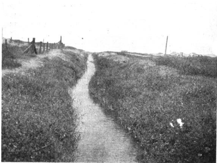
Zanja abierta en "5 de Mayo" Norte, por la Brigada de Zanjeros del Servicio Antilarvario, Veracruz, 1924
