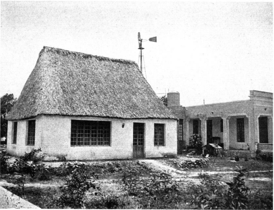
FIG. 1.—Casa construída con los materiales utilizados por los campesinos, pero mejorada en diversos detalles.
