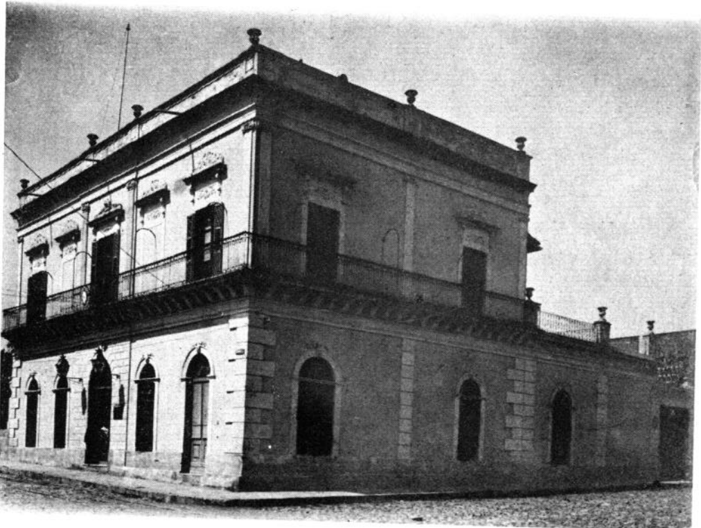
Estación sanitaria de Asunción, Paraguay (Health Station, Asuncion, Paraguay)
