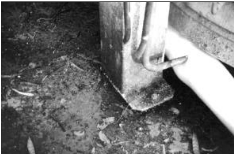
Fotografía 16. Detalle de conexión en los soportes
