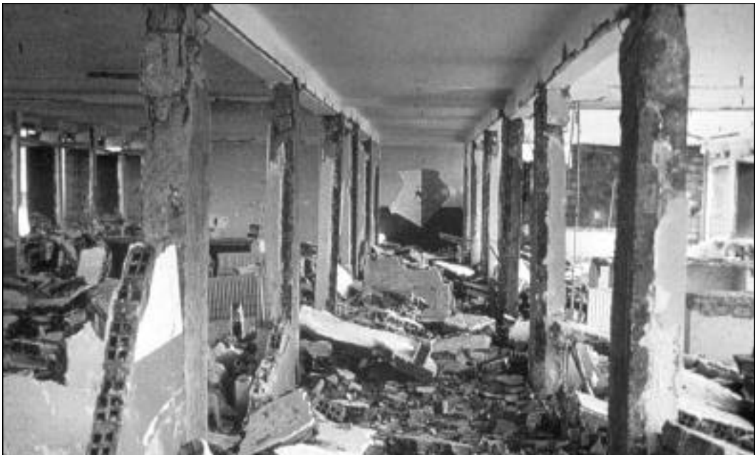
Fotografía 24. Muros destruidos por flexibilidad de la estructura
