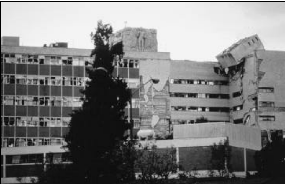
Fotografía 8. Concentraciones de masa, tales como estanques de agua en el techo de hospitales pueden producir daños que comprometan el funcionamiento del hospital.
