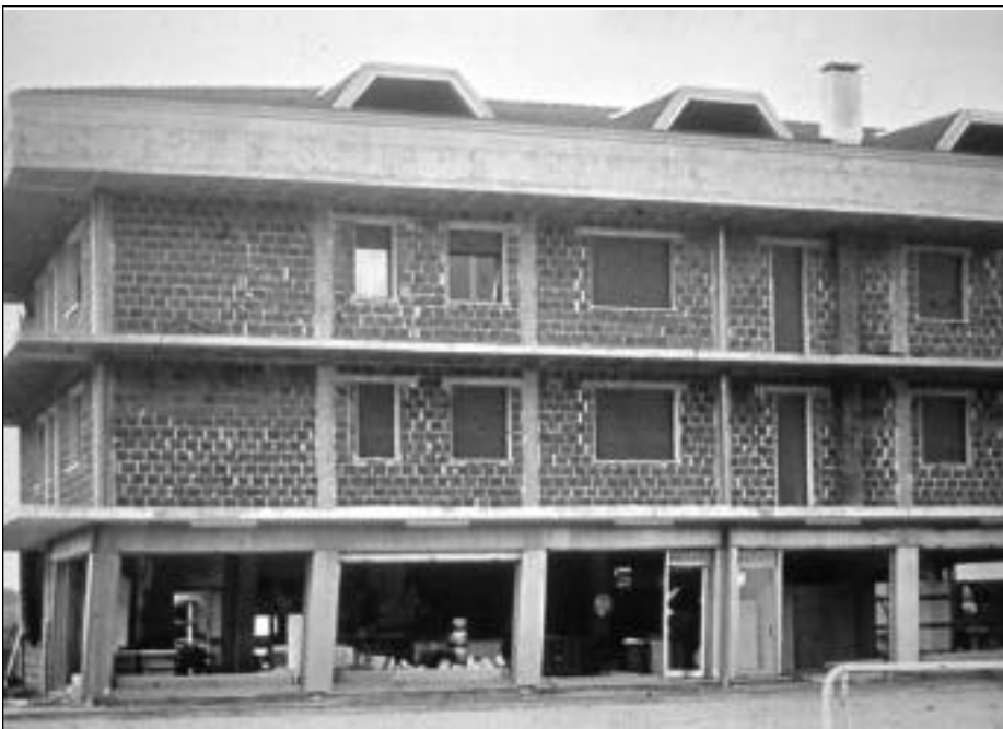
Fotografía 9. Falla en planta baja por piso suave
