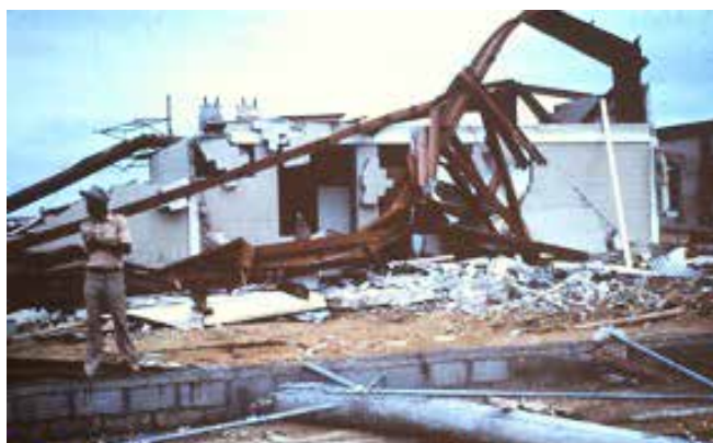
Figura 4. Daños estructurales provocados por el huracán David, 1979, en la zona industrial de Haina de la República Dominicana.
