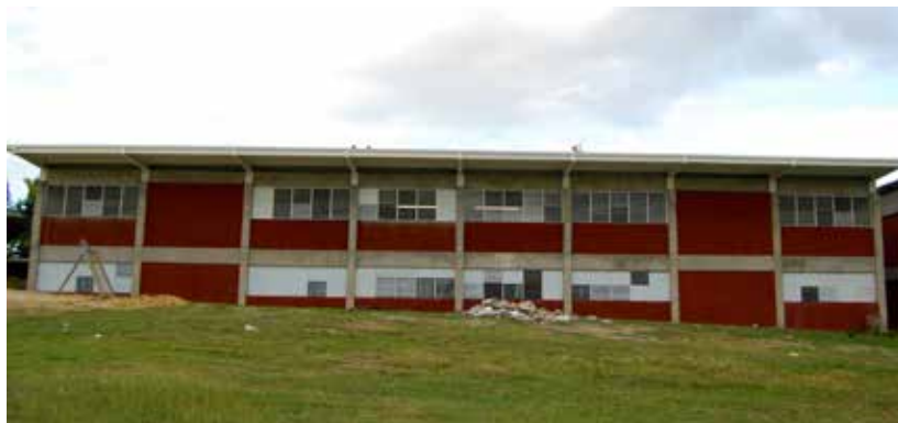
Figuras 7. Edificación terminada después del reforzamiento ( retrofit ).
