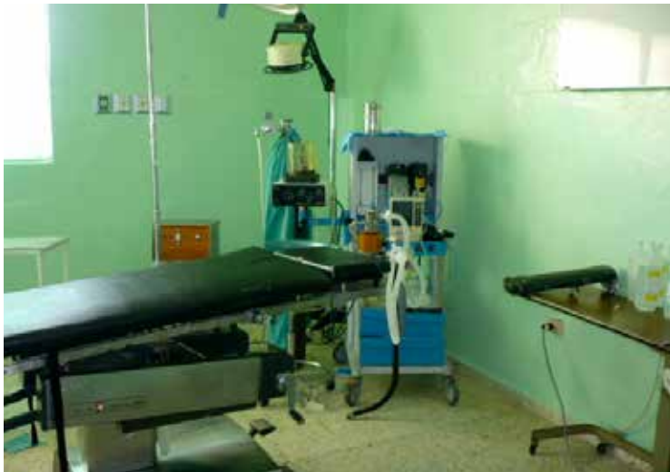
Figura 6. Equipos en áreas críticas sin anclajes ni frenos.
