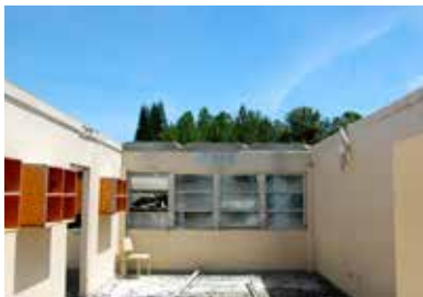
Figuras 4 y 5. Inicio de los trabajos para el proceso de desmantelamiento
