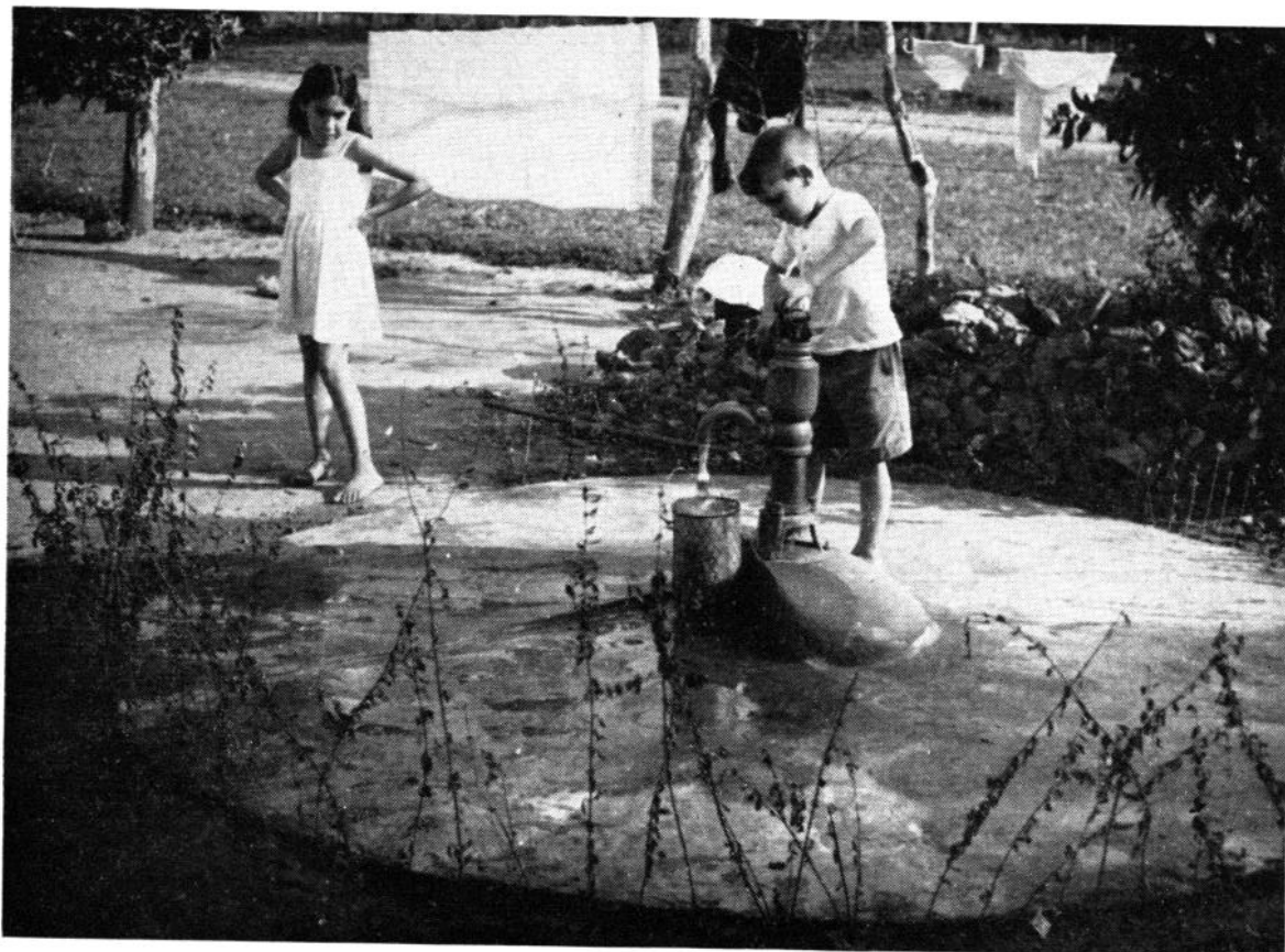
FIG. 5.—Un pozo hincado terminado y en uso.
