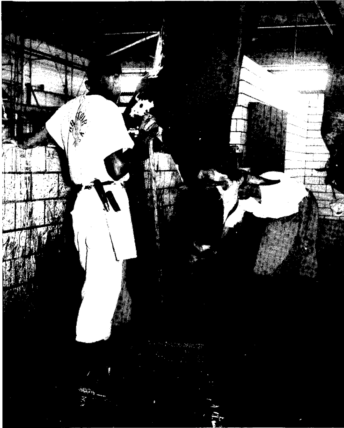
Figura 10. Zona de sangría, con dren en declive y pared de contención de mayólica blanca. Nótese el borde o banqueta.
