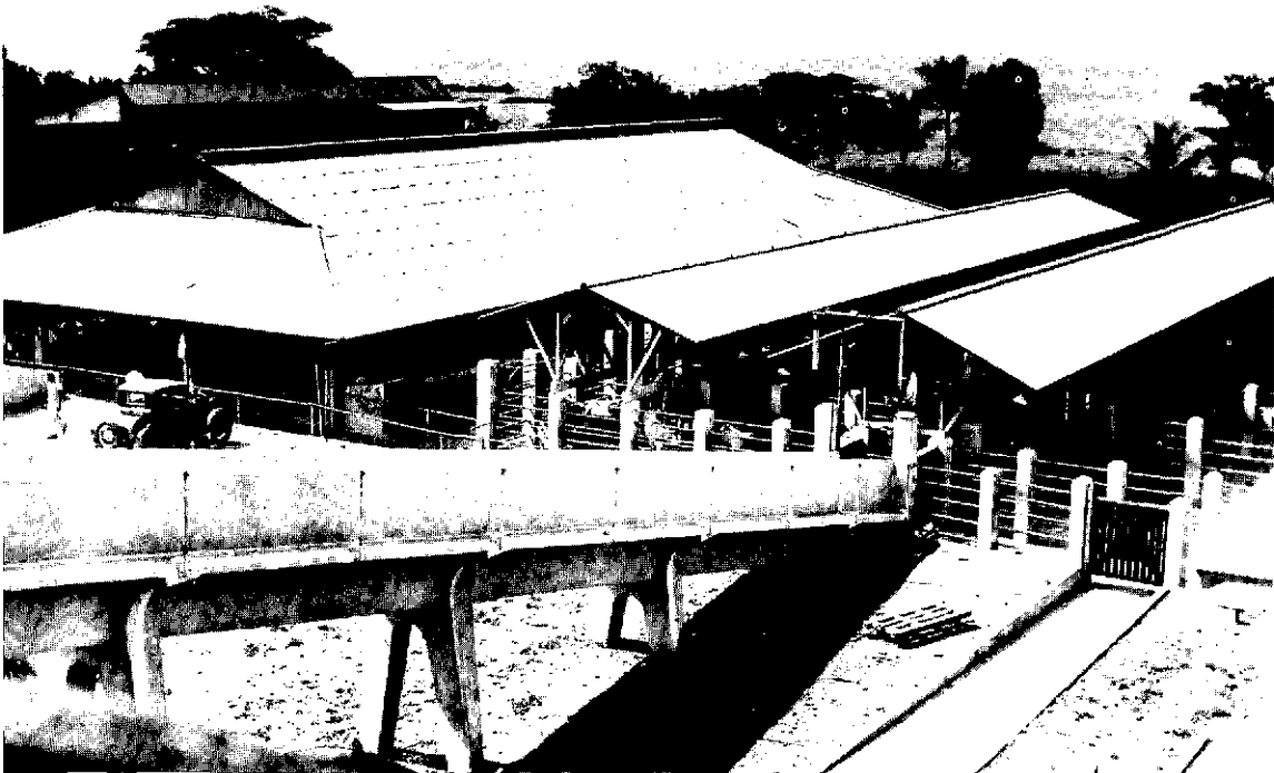
Figura 5. Rampa de concreto para ganado y corrales de encierro techados.
