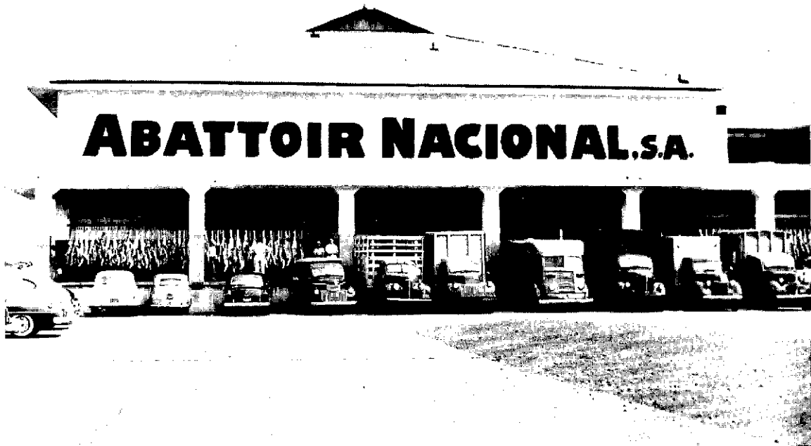
Figura 2. Plataforma de carga del matadero "Abattoir Nacional" de Panamá. Nótese la elevación de la plataforma sobre el nivel del suelo, los rieles aéreos de despacho, y el área anterior de concreto y pedrín.
