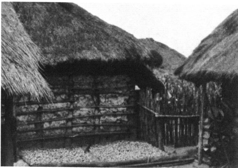
Típica habitación indígena, construida de adobe, barro aprisionado, pisos de tierra y muchas de ellas sin letrinas y con poca ventilación.
